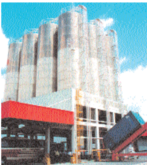
Silos do CDM de Paulínia
