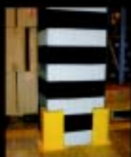
Proteção p/culinas estruturais
