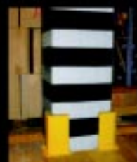
Proteções p/ colunas estruturais
