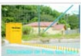
Guard Rail tubular com 300 mm de altura
