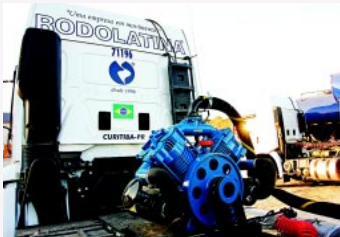
Para a descarga, são utilizados compressores de ar que impulsionam o cimento através do mangote: sistema implementado pela empresa
