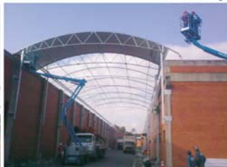
ESTRUTURA ESPECIAL ENTRE DOIS PRÉDIOS
