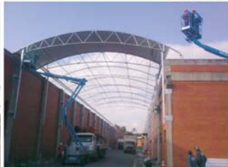
ESTRUTURA ESPECIAL ENTRE DOIS PRÉDIOS
