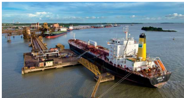
Nos três últimos anos foram investidos cerca de R$1,2 bilhão na construção de acesso ferroviário, armazenagem, infraestrutura portuária e reforma de berços
