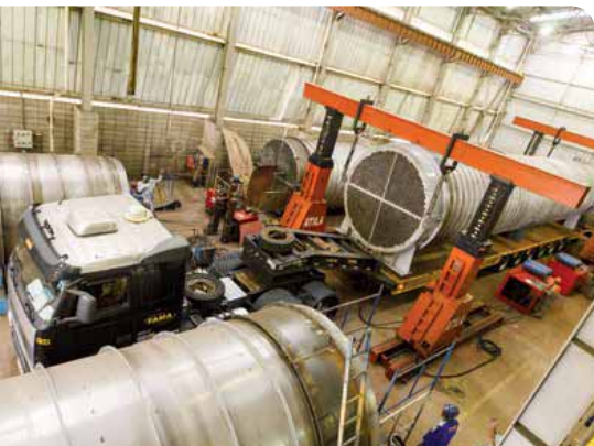
Com a Rigging Industrial, a Fama passa a atuar em diversas etapas da montagem industrial, como na movimentação de peças e equipamentos
