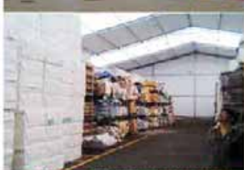
GALPÃO ESTRUTURADO LONADO
