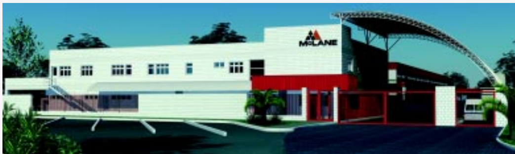
Projeção do CD de Resende, após o término das obras, previsto para 2010
