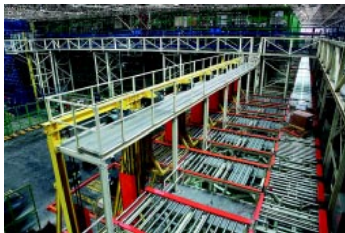
O uso adequado das estruturas garante maior confiabilidade
